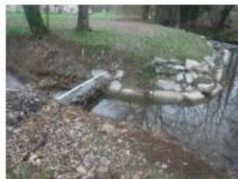
Après travaux : enrochement et mise en place d'une grille sur le bief
