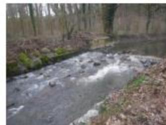
Après travaux : Création d'un seuil en rive gauche et d'une rampe en rive droite
