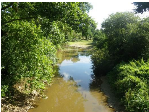
Vue aval pont en 2014
