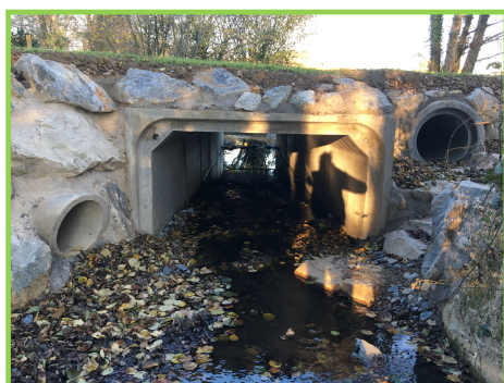
Remplacement de 4 passages busés par 2 ponts- cadre et 2 passerelles
