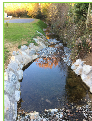
Recharge lourde sur les linéaires de ruisseaux entre les ouvrages
